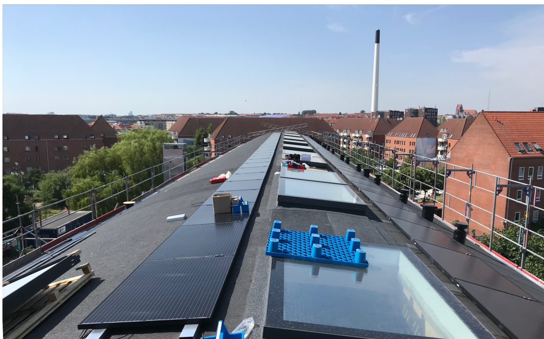
Igangværende byggeprojekt på Heimdalsgade 39, 2200 København N. Montering af solceller og ovenlysvinduer.
